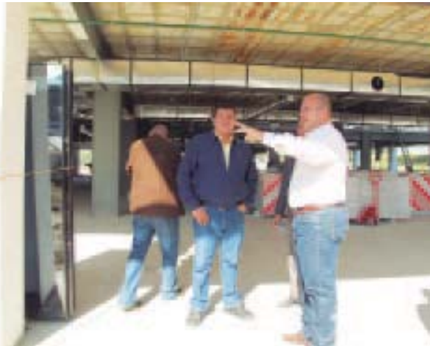
Supervisión de las obras del Centro Administrativo Tlajomulco
