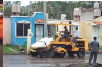
Labores de limpieza en Eucaliptos
