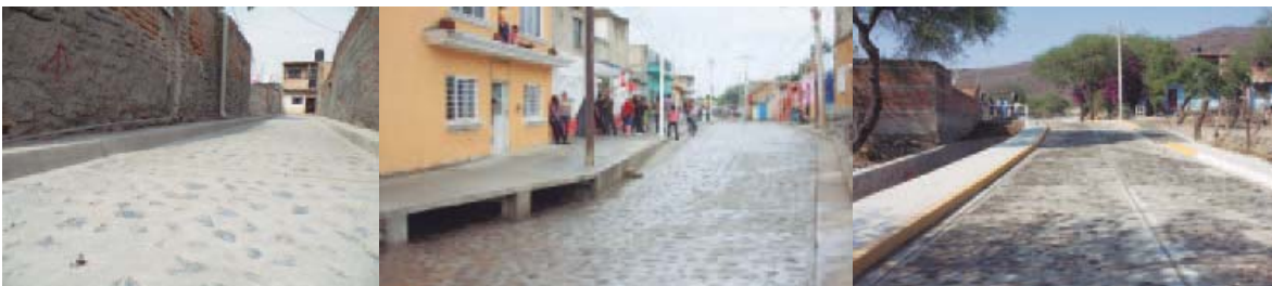
Renovación de vialidades y redes de alcantarillado en Santa Cruz del Valle, Santa Cruz de las Flores y Santa Cruz de la Loma
