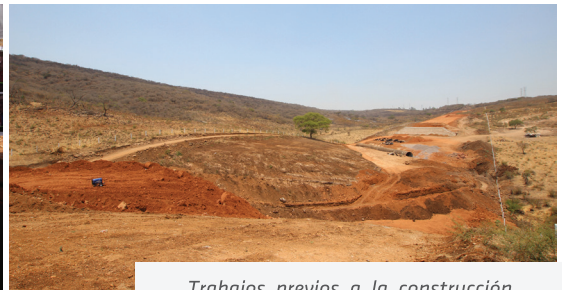
Trabajos previos a la construcción del Macrolibramiento en la zona de Tlajomulco
