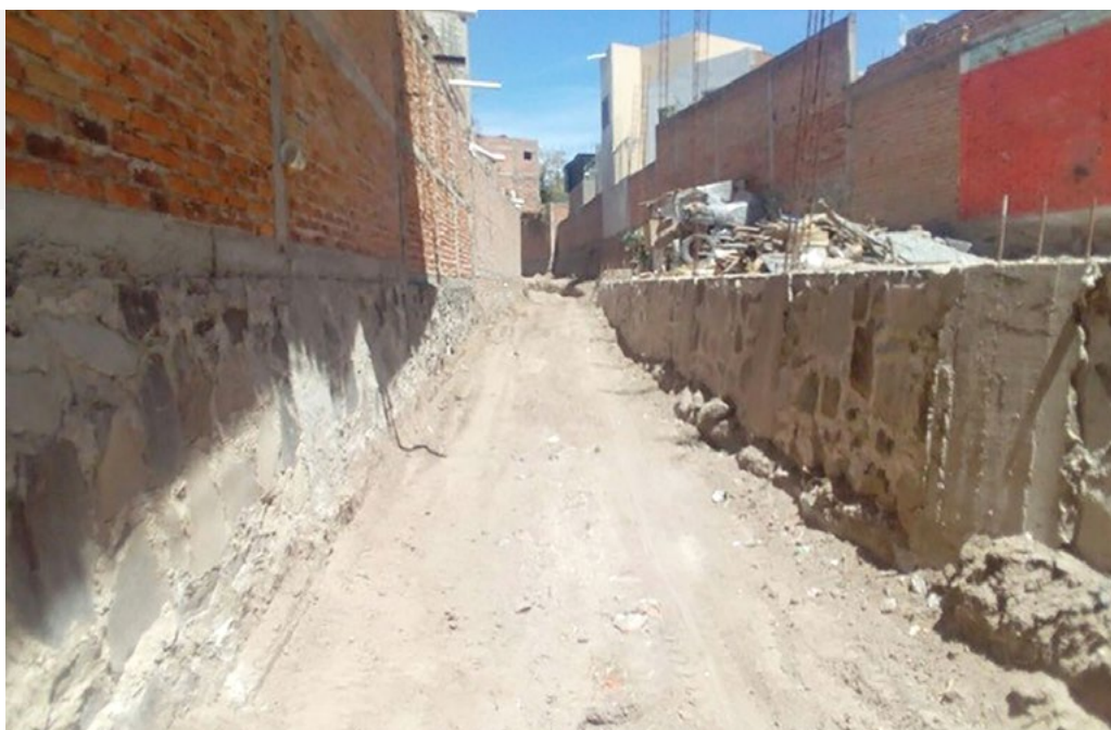
► Canal pluvial en la Cabecera Municipal entre calle Juárez y Flaviano Ramos
