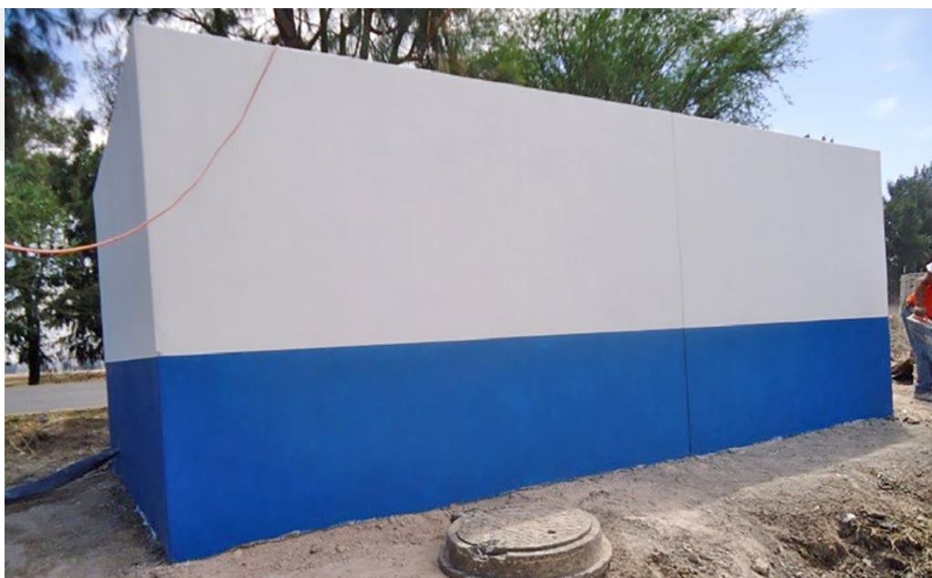
► Colector de aguas residuales en San Miguel Cuyutlán
