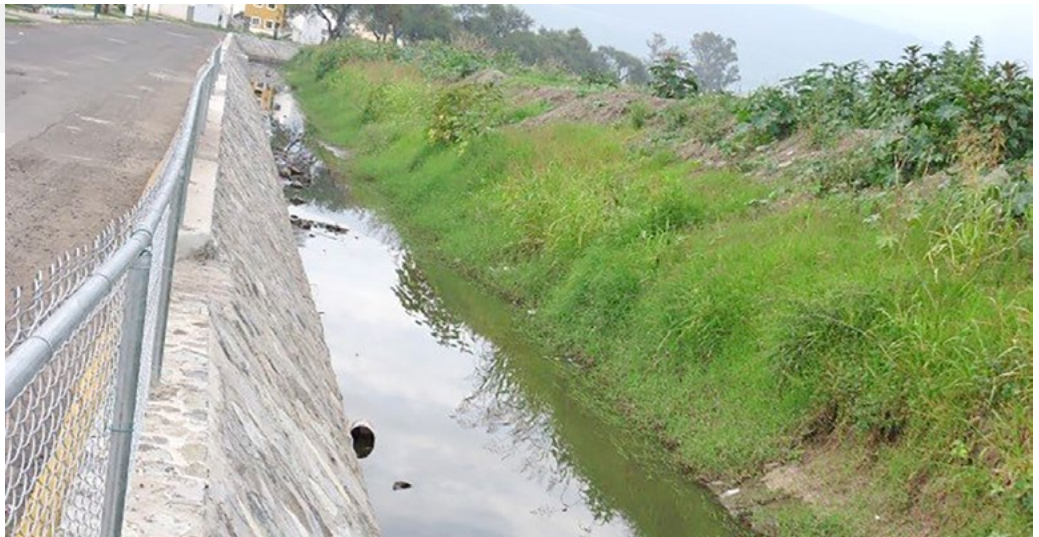
► Drenaje pluvial en el fraccionamiento Los Eucaliptos
