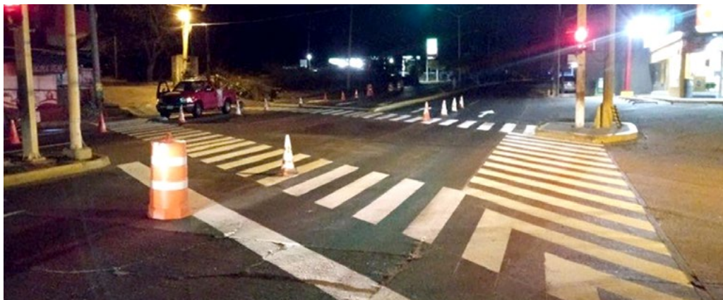
► Av. Pedro Parra Centeno rehabilitada y balizada
