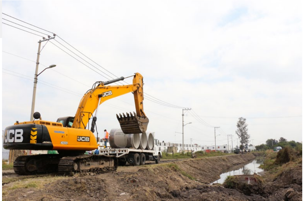
► Obra de colector de agua en Jardines del Edén
