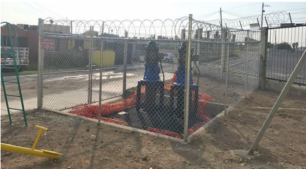
► Cárcamo de tormenta en fraccionamiento Villas de la Hacienda
