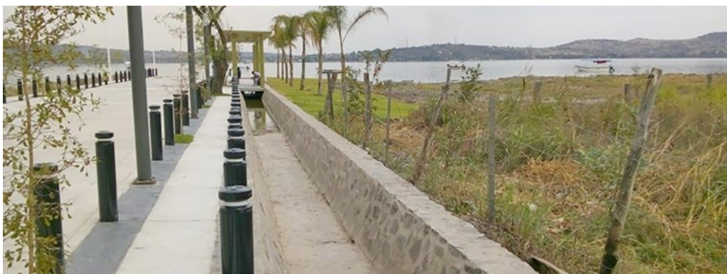
► Pavimentación de calle Emiliano Zapata en Rivera de Cajitlán
