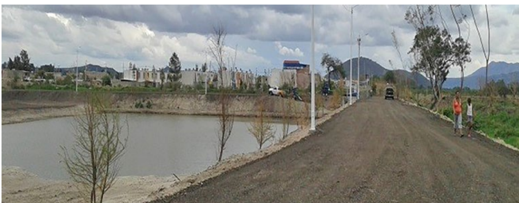
► Vaso Regulador en el fraccionamiento de Los Eucaliptos
