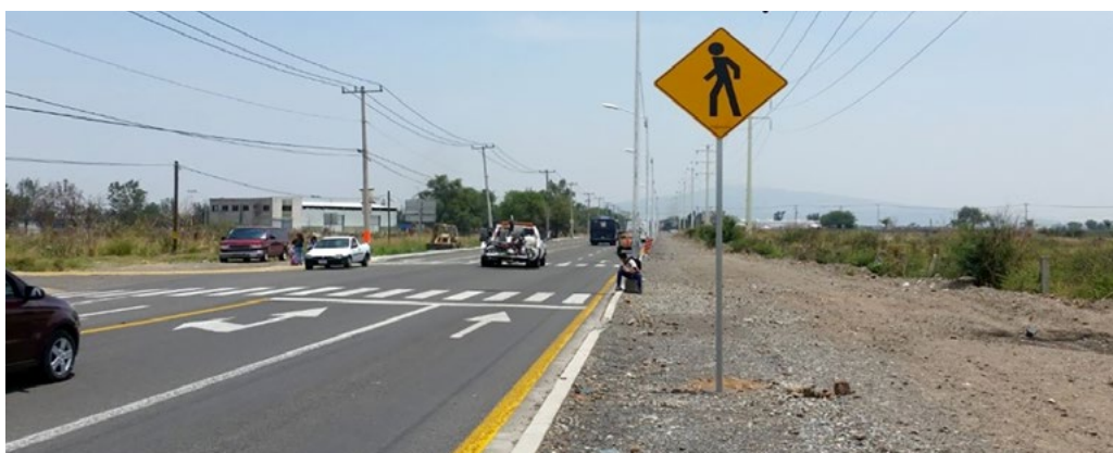
► Señalética instalada en cruce de avenida
