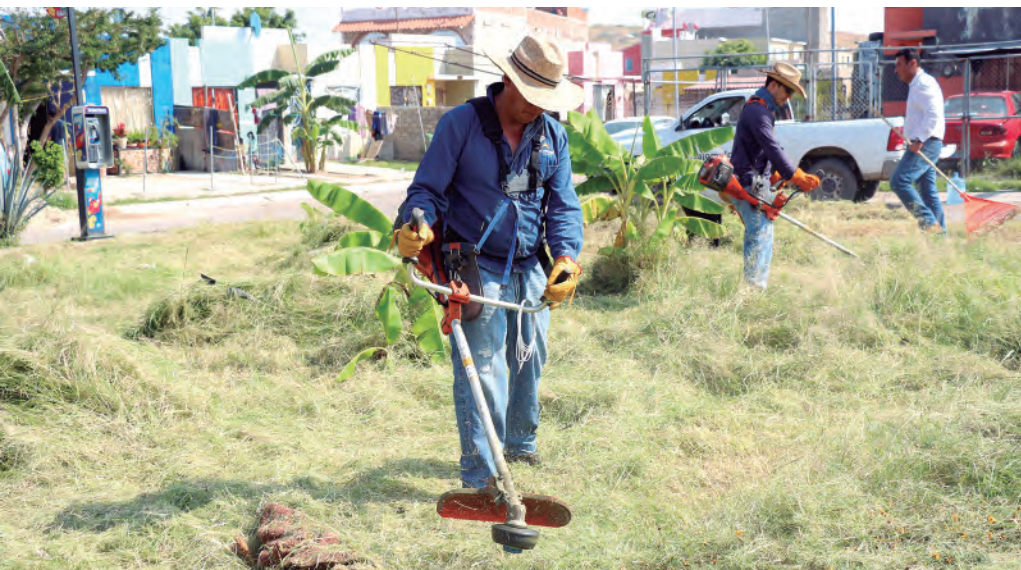
► Realización de obras de rehabilitación en Chulavista por el programa Rescate de Espacios Públicos
