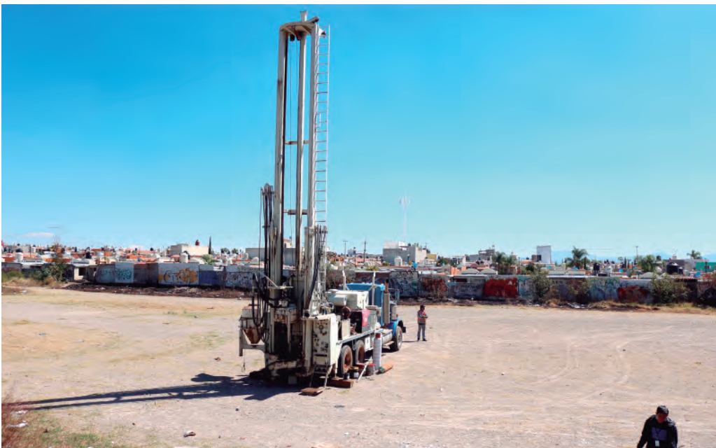
► Sistema de Agua Potable, Alcantarillado y Saneamiento (SIAT), durante intervenciones de pozos
